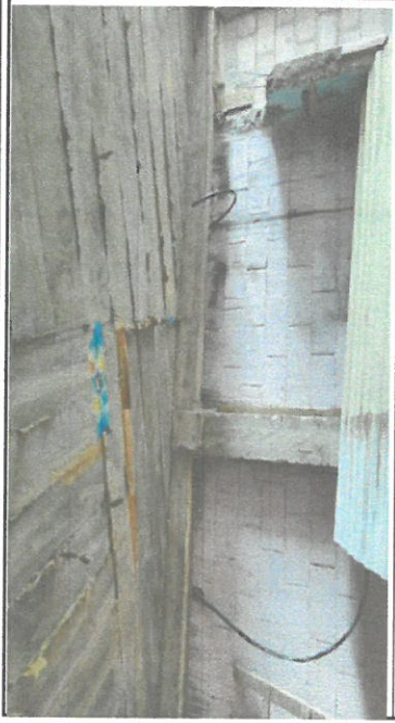
Foto 1, Suministro y Tallado de columnas y vigas. (módulo de cocina).
