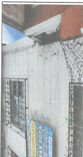
Foto 5 Suministro e instalación de lámina troqueda legítimo calibre 26.
